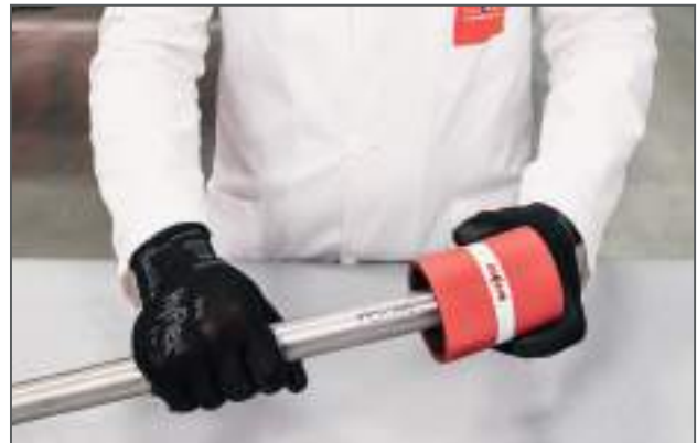
Sbavatura del tubo / Deburring the pipe
